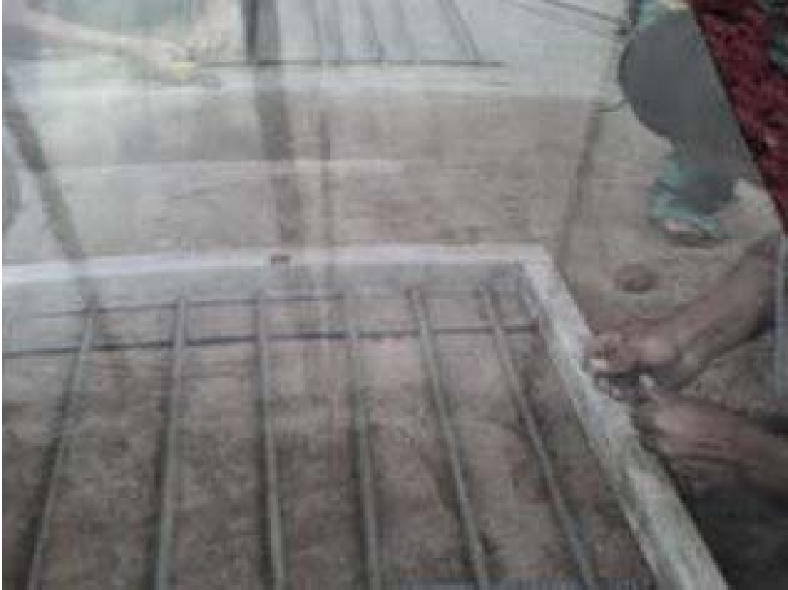
ARMADO Y CONSTRUCCION DE MOLDES DE PLATAFORMAS REFORZADAS DE LAS COCINAS MEJORADAS
