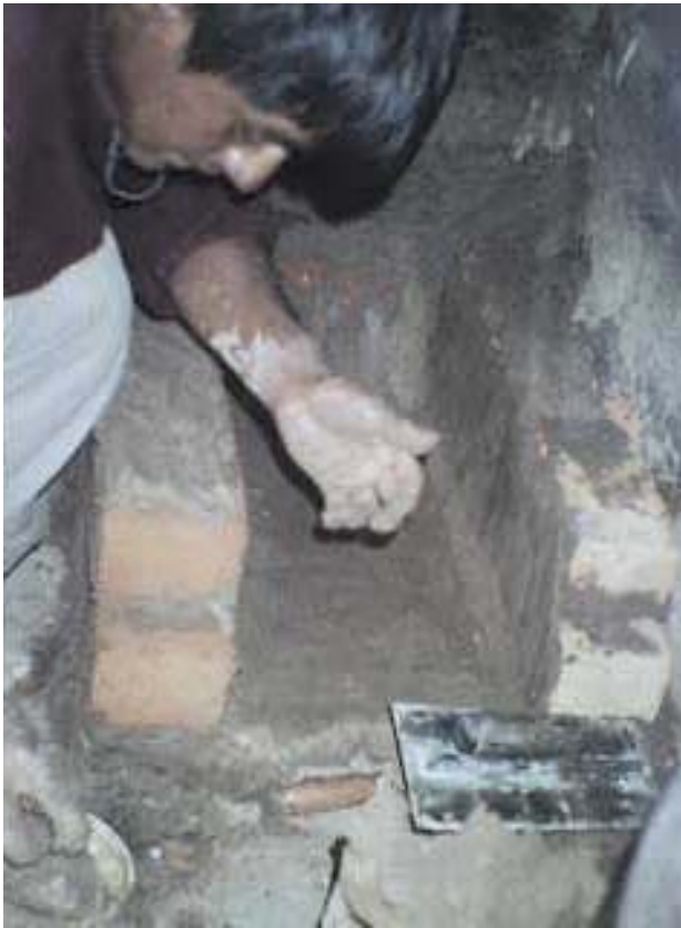
CONSTRUCCION Y PREPARACION DE LA BASE PRINCIPAL CON MATERIAL NOBLE PARA SERVIR DE SOPORTE PRINCIPAL DE LAS PLATAFORMAS DE CONCRETO DE LA COCINA MEJORADA.
