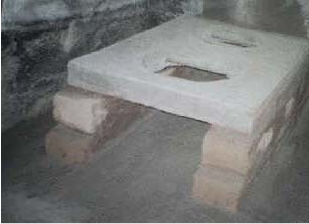
INSTALACION Y ANCLAJE DE LA PLATAFORMA REFORZADA DE LA COCINA MEJORADA, OBSERSE LOS AGUJEROS ABIERTOS PARA LA UBICACIÓN DE LAS CACEROLAS
