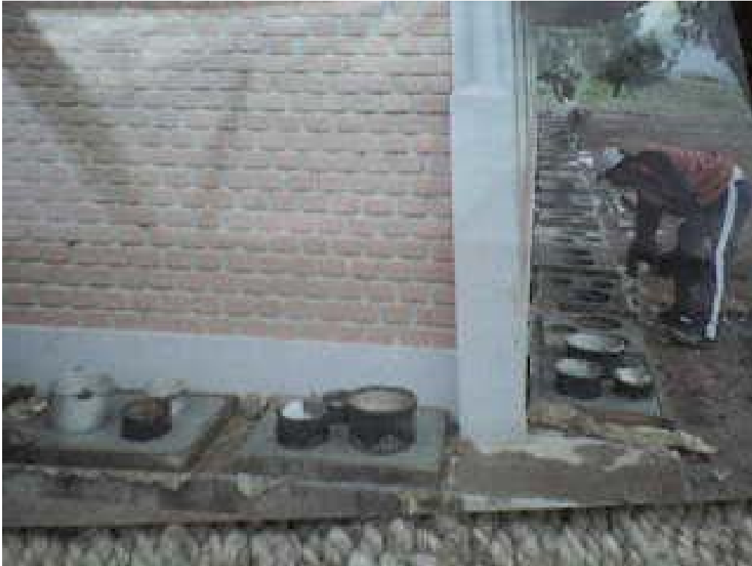
CONSTRUCCION MASIVA DE LAS PLATAFORMAS PARA COCINAS MEJORADAS
