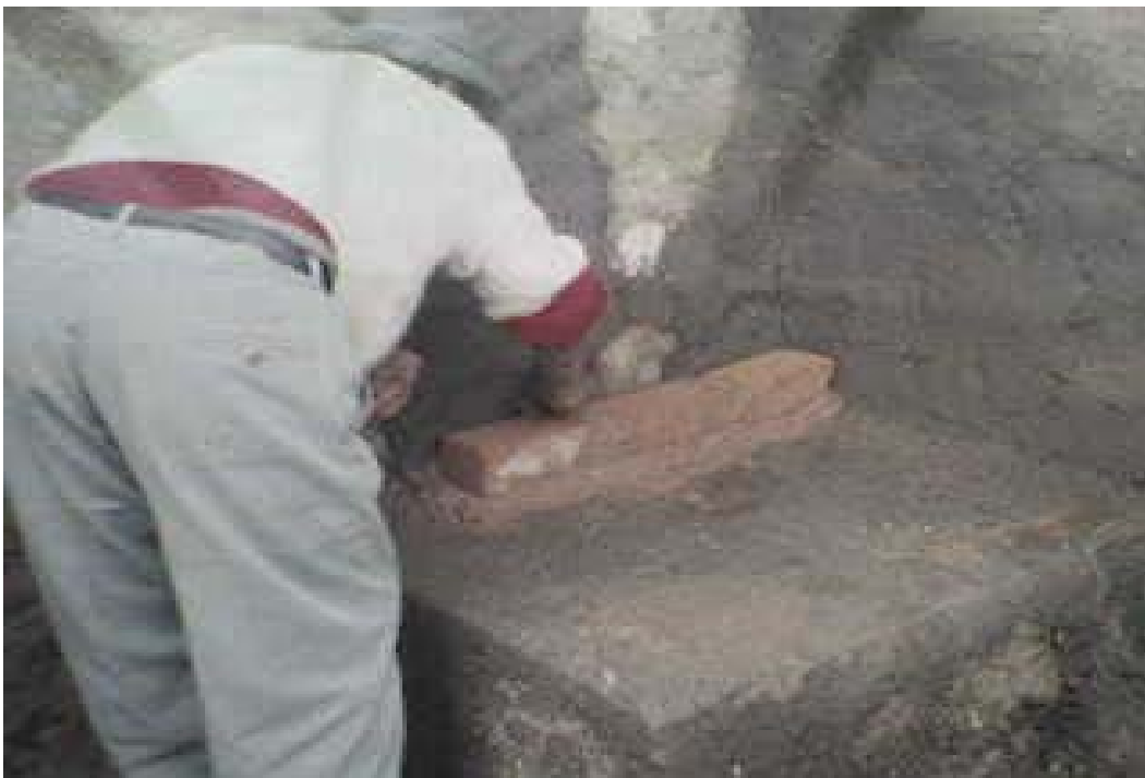
ACABADO Y RECUBRIMIENTO DE LA BASE PRINCIPAL E INICIO DE CONSTRUCCION DEL SOPORTE DE LA PLATAFORMA REFORZADA
