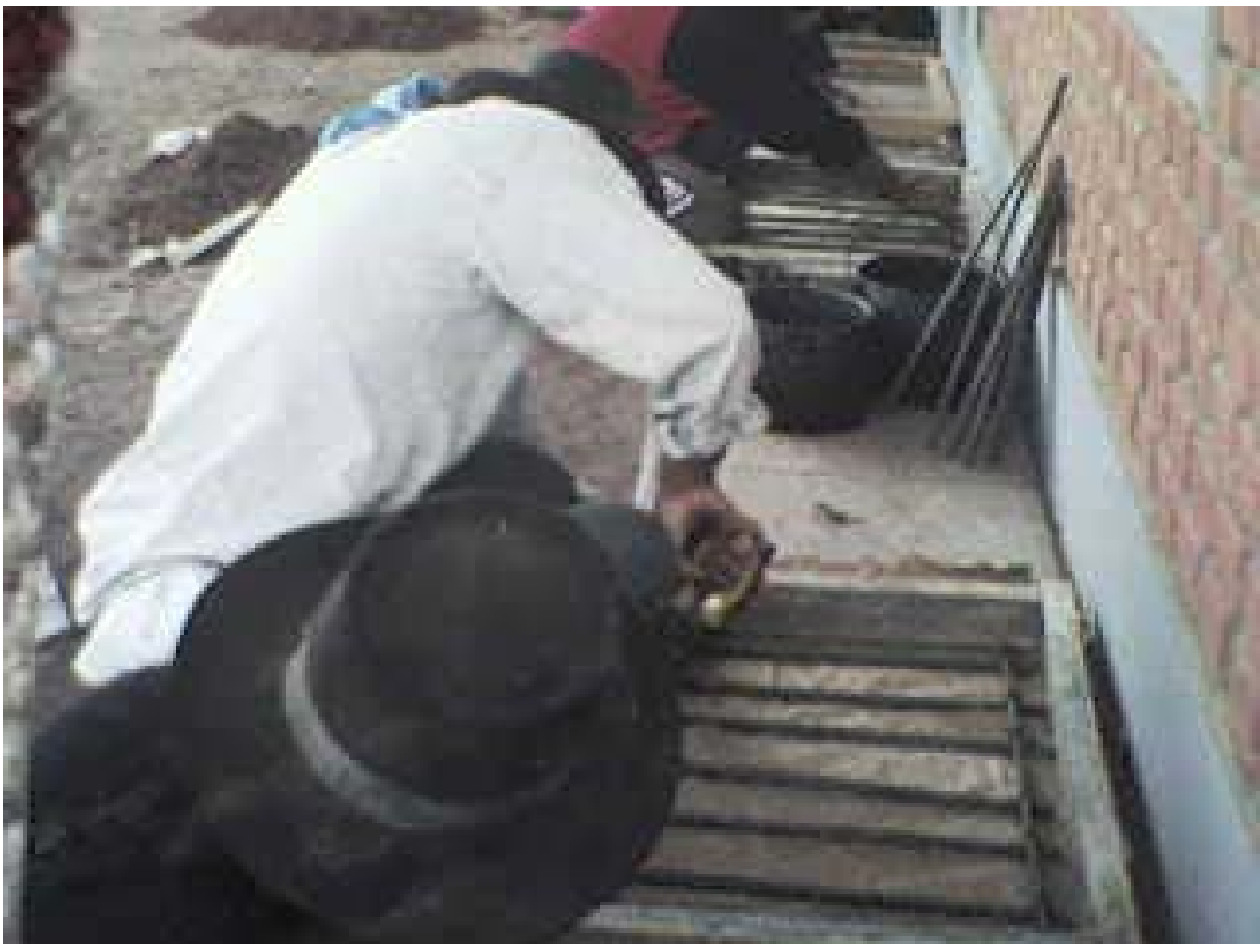
ARMADO Y CONSTRUCCION DE MOLDES DE PLATAFORMAS REFORZADAS DE LAS COCINAS MEJORADAS
