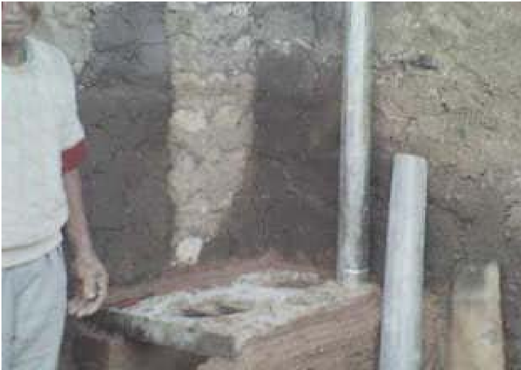
INSTALACION DE LA CHIMENEA DE LATON PARA LA SALIDA DE LOS HUMOS Y OLORES CONTAMINANTES
