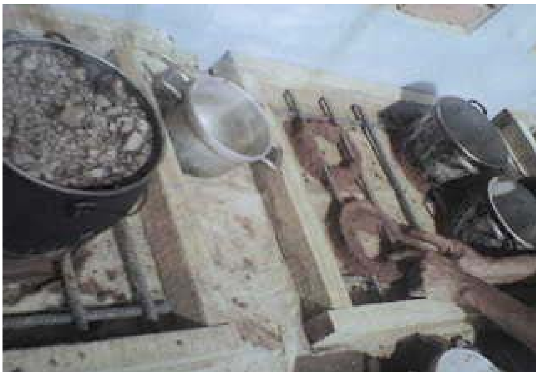
MEDICION Y MOLDEO DE LAS HORNILLAS DE LA PLATAFORMA DE LAS COCINAS MEJORADAS
